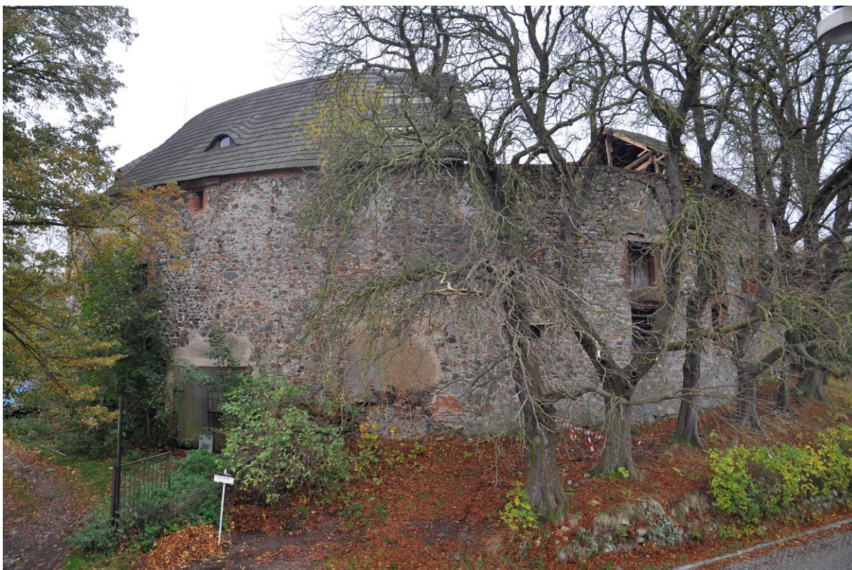
celkový pohled od severozápadu
