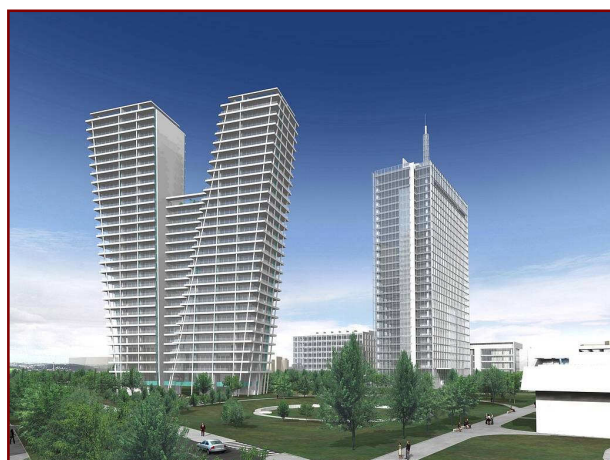
Bytový objekt na Pankráci v Praze Staví se
