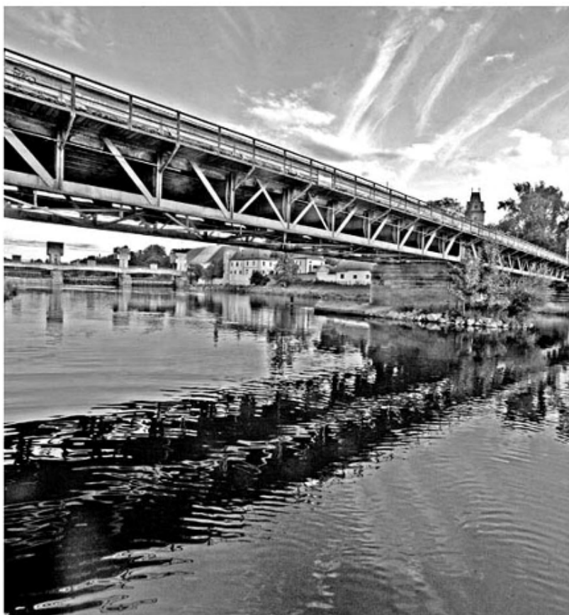
Nýtový přehradový most Brandýs nad Labem – stav r. 2009
