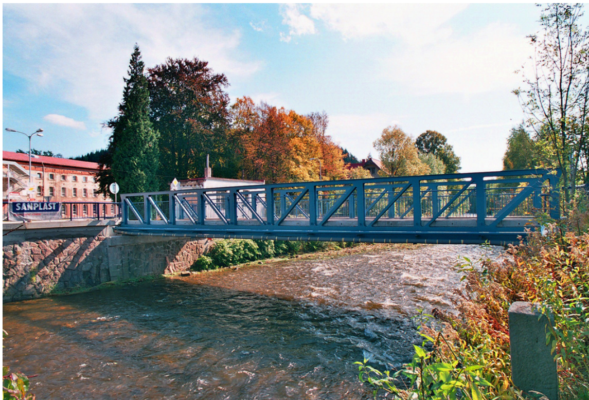
KOMPLETNÍ VÝMĚNA OCELOVÉ KONSTRUKCE
