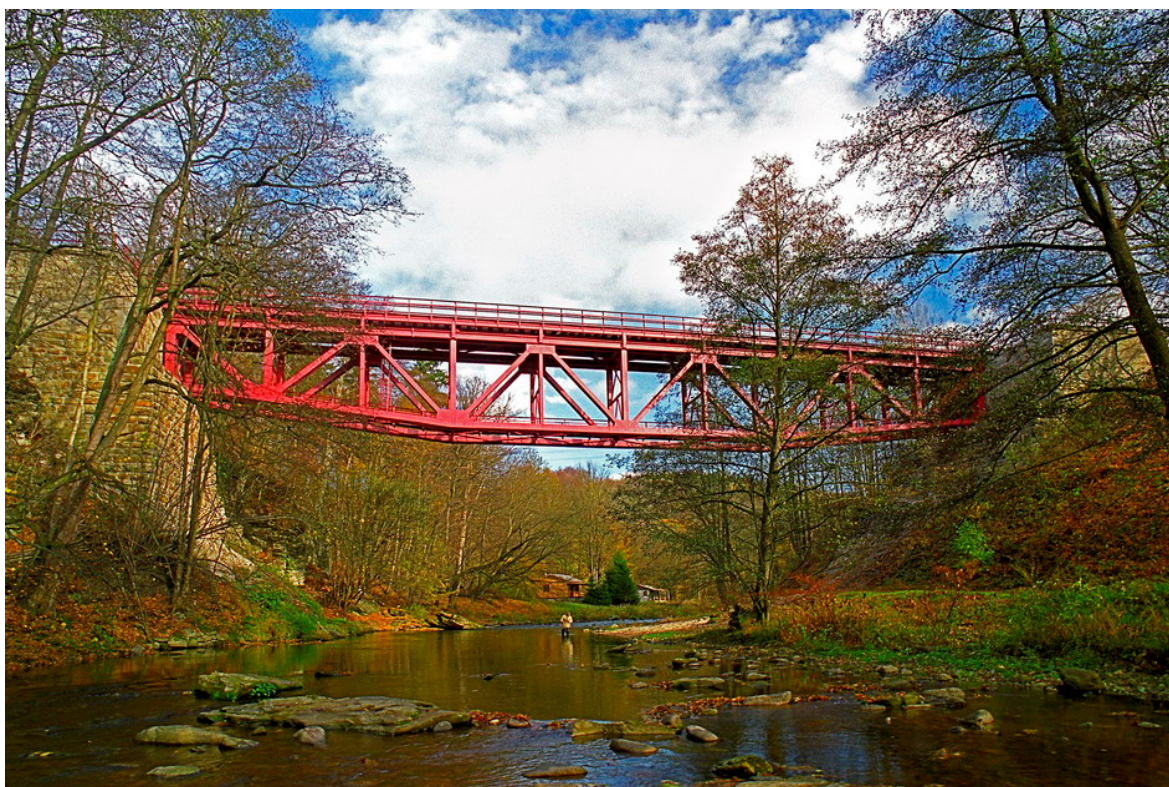
REKONSTRUKCE 60LET STARÉHO OCELOVÉHO MOSTU
