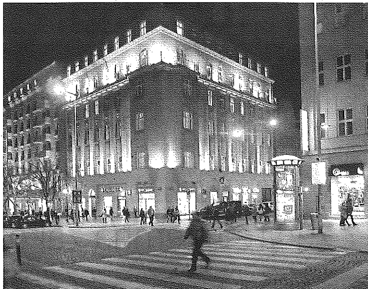
Dům číslo 47 na Václavském náměstí by se měl bourat. Nahradit by jej měla vyšší novostavba. FOTO | NEBOUREJTE DŮM VÁCLAVSKÉ NÁMĚSTÍ ČÍSLO 47/FACEBOOK
