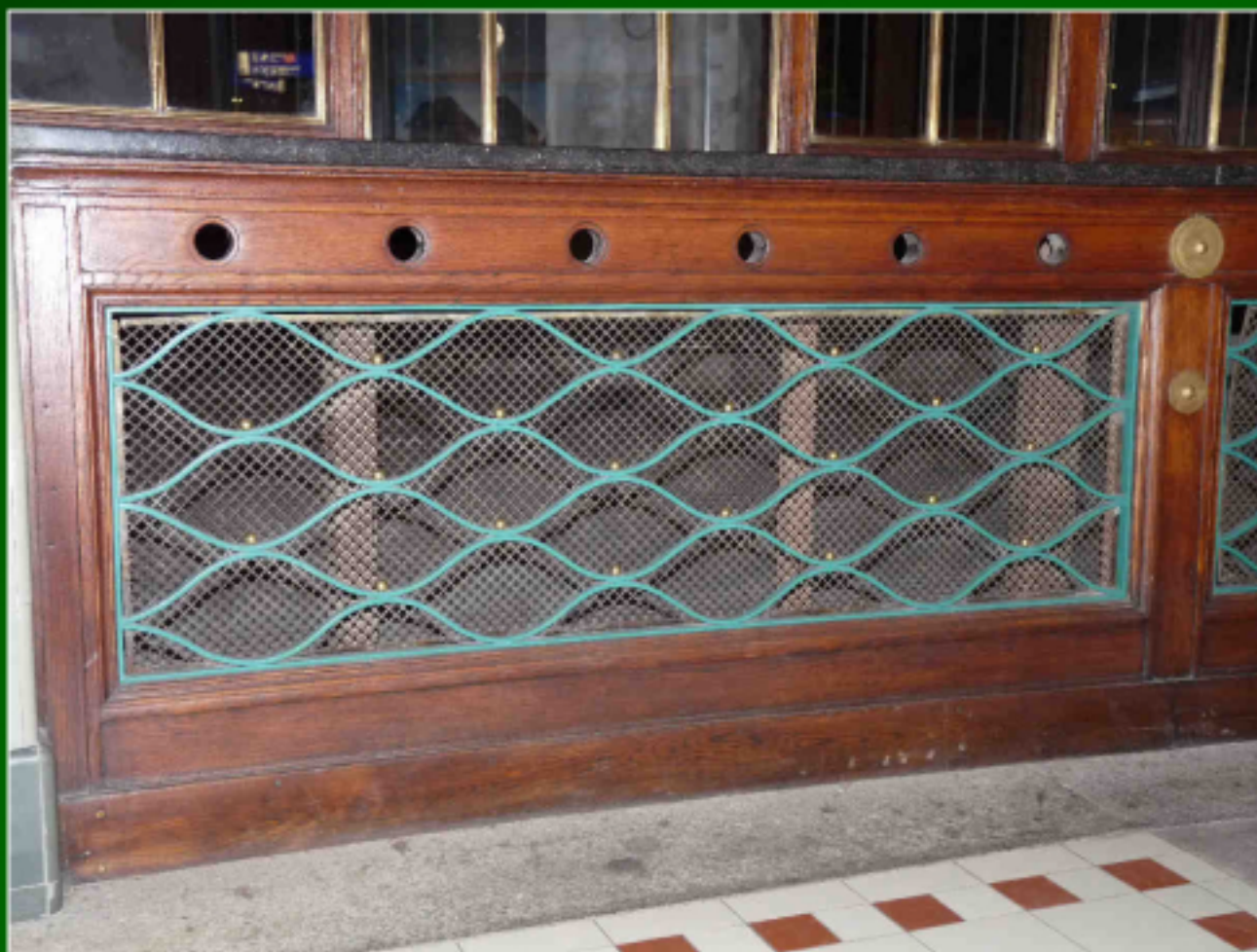
Obr. 13: není obnoveno mosazné žeberkové pletivo, nedostačující uchycení pletiva, mosazné nýty opatlané barvou.
