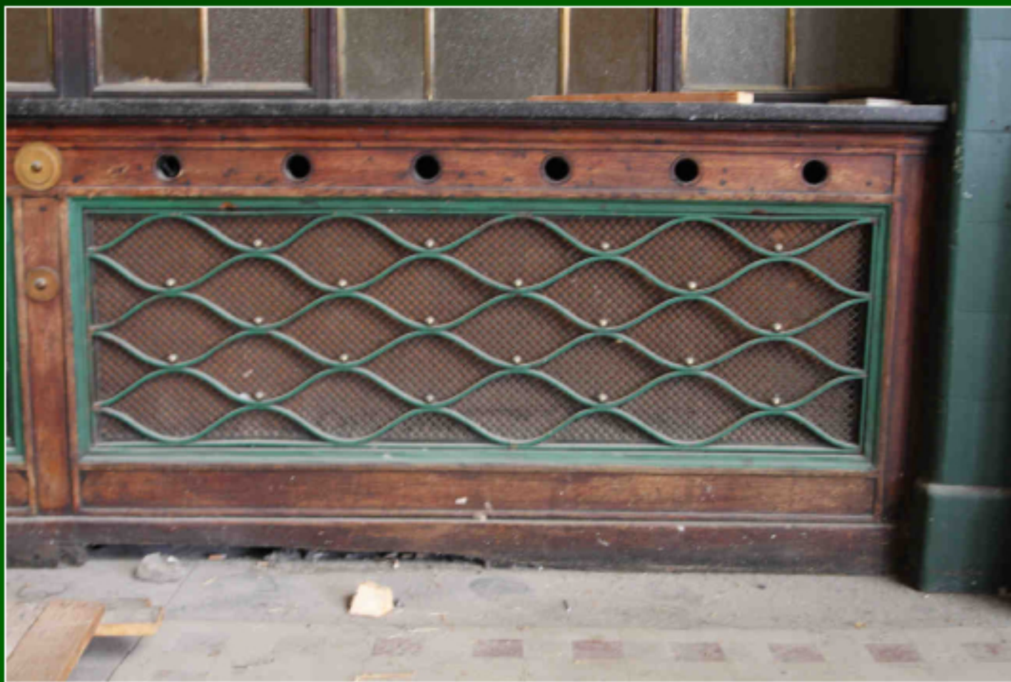
Obr. 12: paraván radiátoru levý – stav před rekonstrukcí.
