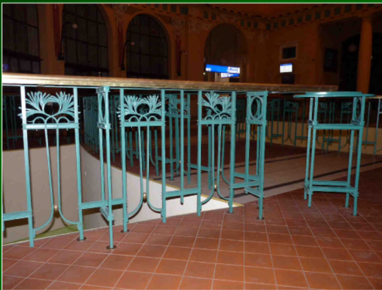
Obr. 7: detail chybějící části listů dekoru zábradlí. Naprosto bezdůvodně vyměněná cenná historická secesní dlažba!
