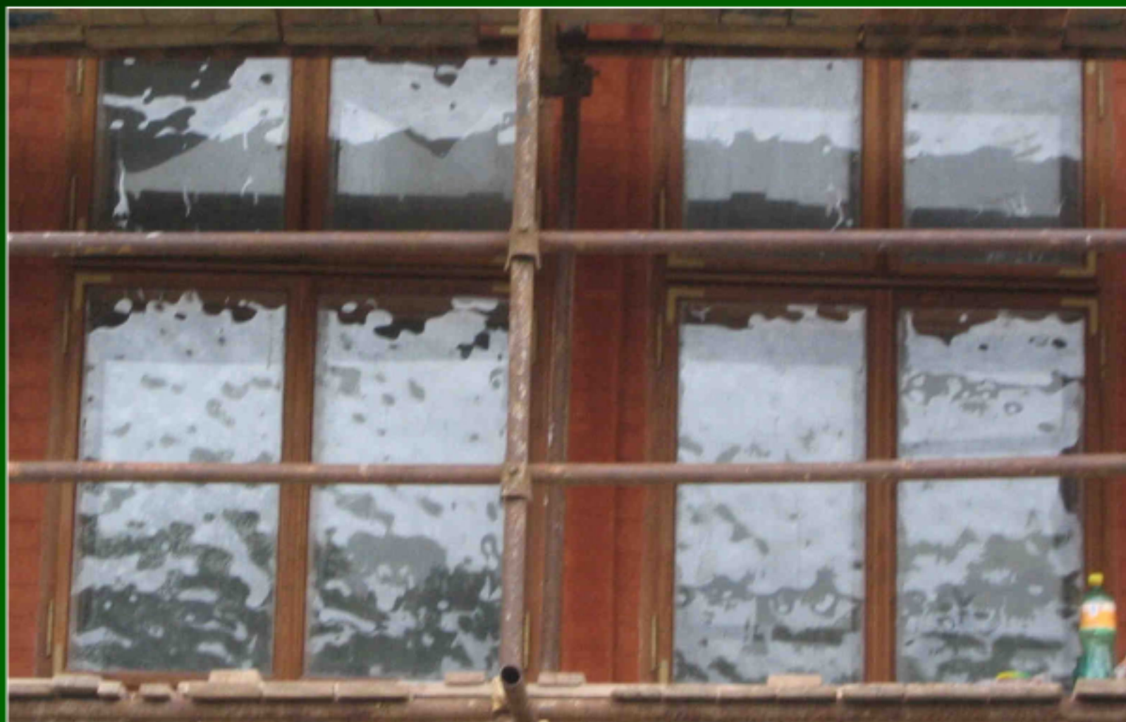
Obr. 16: příklad zasklení historických oken náhražkou foukaného skla vyrobeného degradací floatu.
