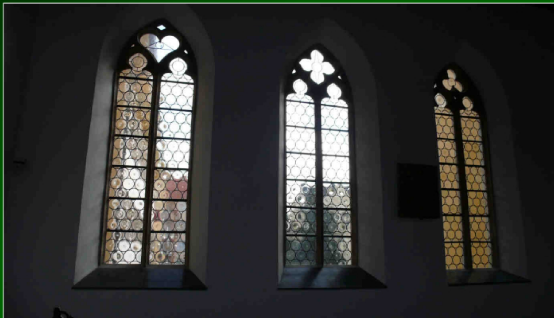
Obr. 22: obnovené vitráže – pohled z interiéru.
