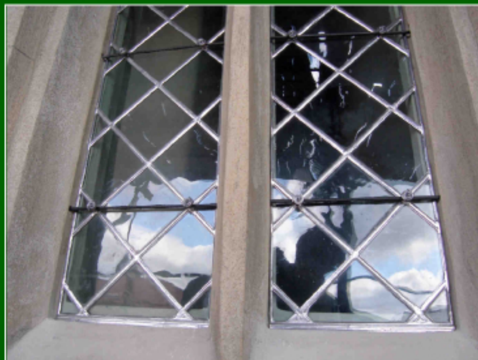
Obr. 15: detail restaurované vitráže s doplněním foukaným sklem.
