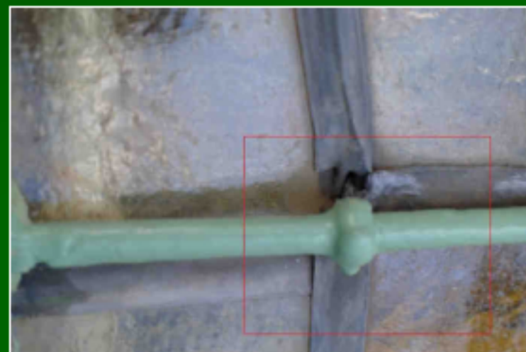
Obr. 3: detail ponechané odtržené příchytky výztuže.
